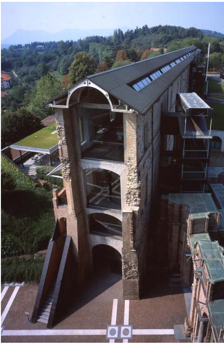
Torino, Castello di Rivoli: la Manica lunga dopo gli interventi di restauro (progetto arch. A. Bruno).
