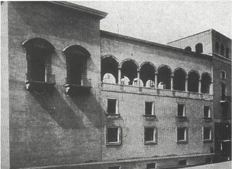
Palermo, Museo Nazionale (ex-casa conventuale dei Padri Filippini): veduta della fronte su via Roma prima e dopo i lavori di restauro eseguiti tra il 1939 e il 1948 (progetto G. De Angelis d'Ossat).
