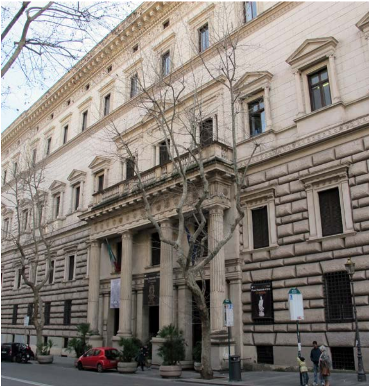
Roma, Palazzo Brancaccio dopo l'intervento di restauro.
