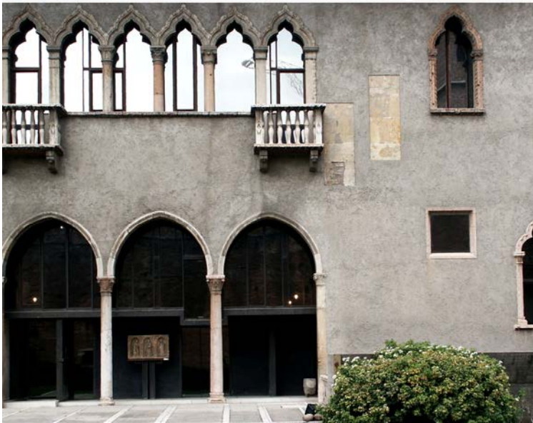
Verona, Museo di Castelvecchio: interventi di allestimento museale di Carlo Scarpa.
