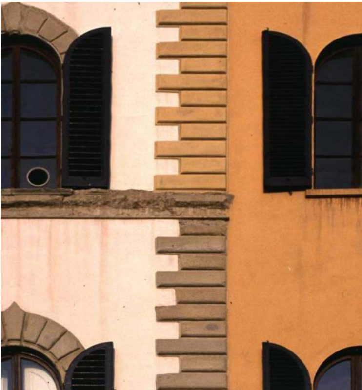
Firenze, intervento di coloritura della facciata derivante da una errata interpretazione della sintassi architettonica.
