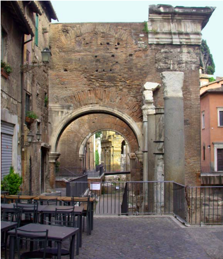
Roma, Portico di Ottavia: il sistema di percorsi di fruizione per il pubblico.
