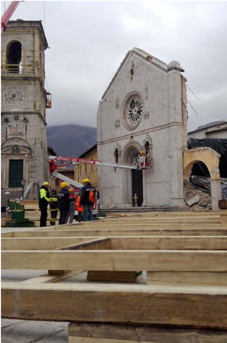
Norcia (PG): la basilica di San Benedetto dopo gli eventi sismici del 2016.
