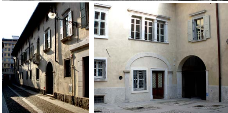
Udine, Palazzo Caiselli prima dei lavori di restauro e a lavori ultimati (progetto prof. arch. P. Ruschi).
