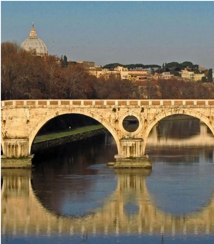
Roma, ponte Sisto prima e dopo l'intervento di restauro (progetto G. Miarelli Mariani).
