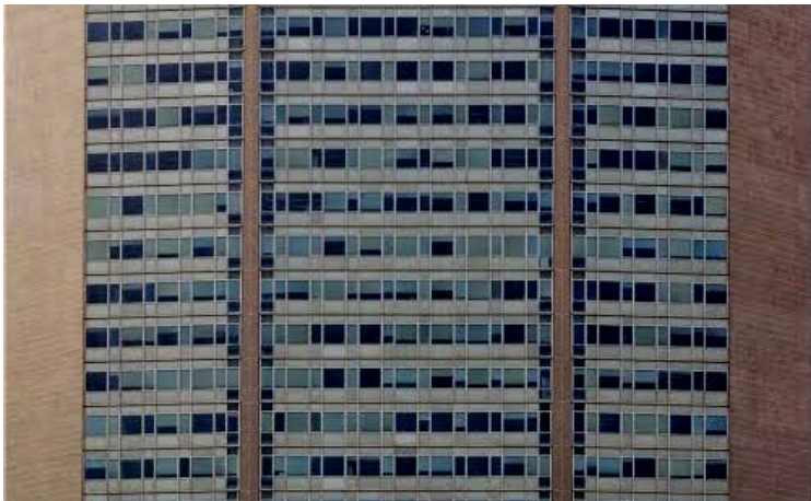
Milano, Grattacielo Pirelli (Gio Ponti e P.L. Nervi, 1956-61). L'edificio dopo l'intervento di restauro.
